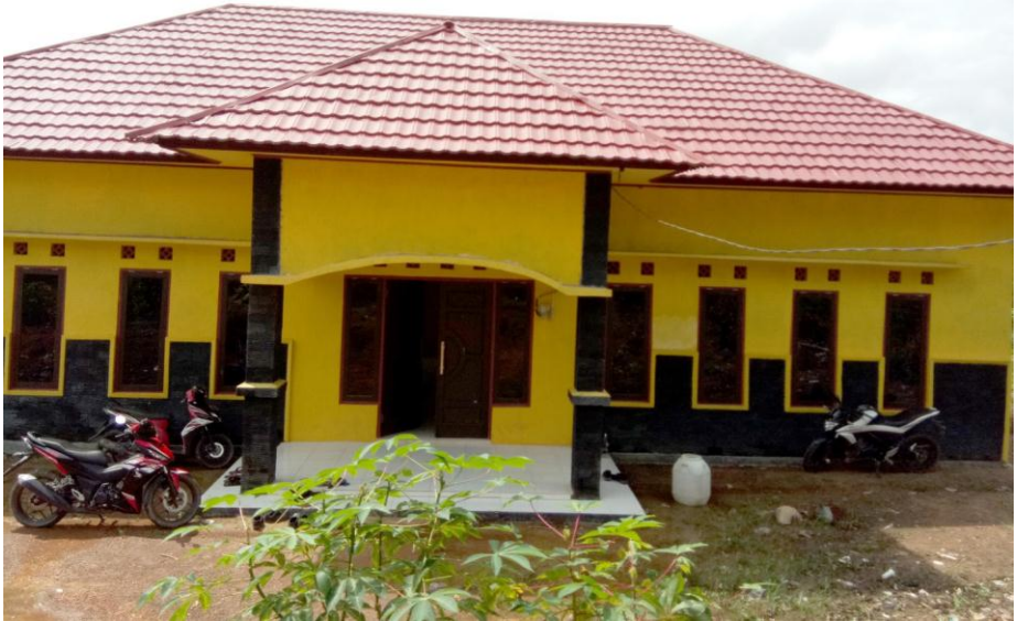
Bangunan dan gerbang SMAN Arut Utara (kiri) dan bangunan asrama (atas)
